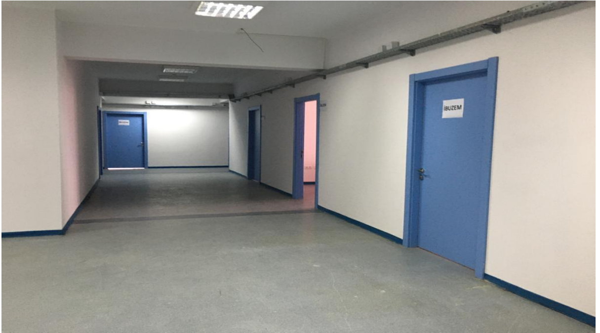
Eski Kütüphane Binası büyük onarımına ait görsel
